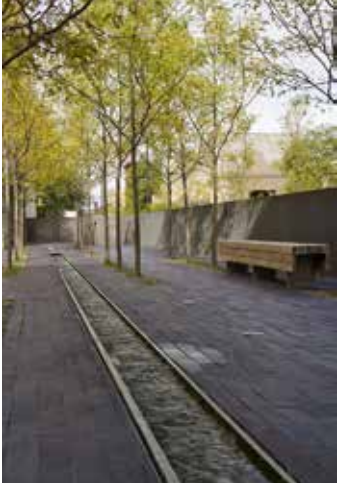
Zichtbare waterafvoer in openbare ruimte
