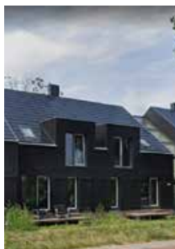
zonnepanelen geïntegreerd in dak
