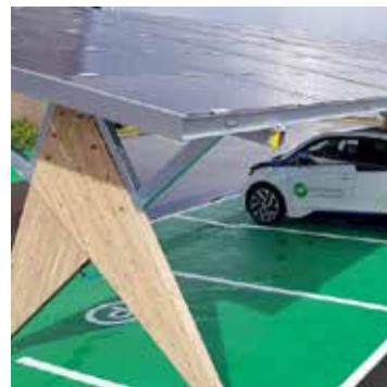
overkapping met zonnepanelen
