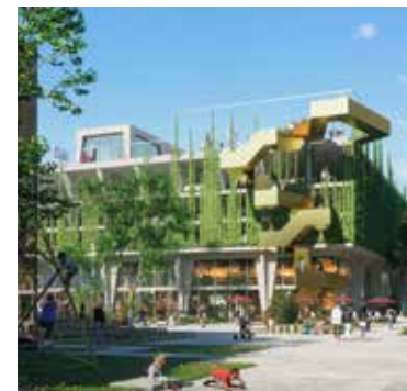
parkeergarage met voorzieningen in plint
