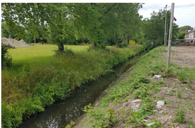
Sloten Pelmolenpad: steil talud, lage waterstand en oeverbeplanting
