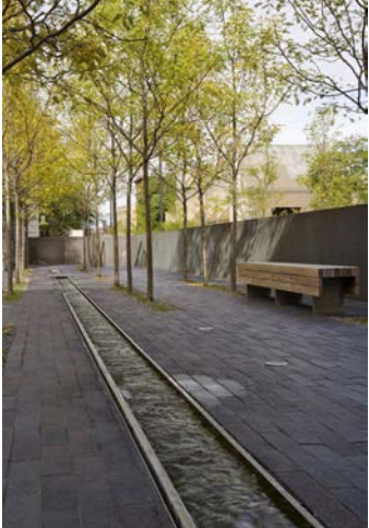
Zichtbare waterafvoer in openbare ruimte
