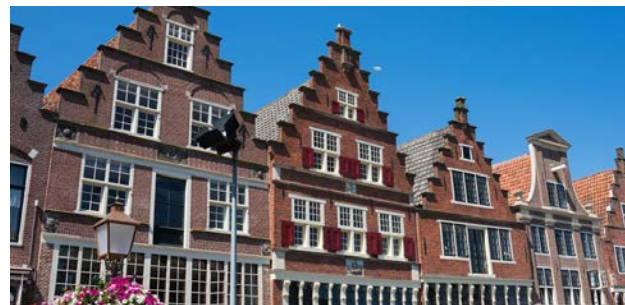
Samenhangend kleur en materiaalgebruik in rode tinten.
