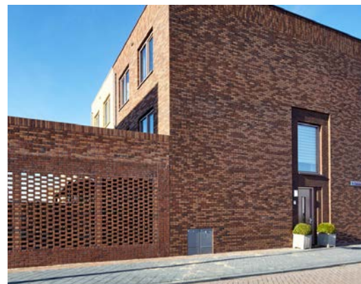
Hoekwoning met tuinmuur
