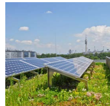
combinatie van zonnepanelen en groendak
