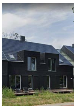
zonnepanelen geïntegreerd in dak
