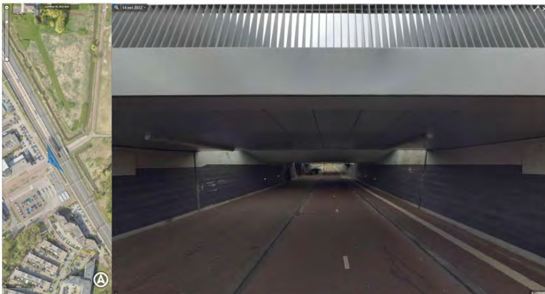
Tussen de rails ter hoogte van station Utrecht Lunetten (fietspad 4,1 m breed)
