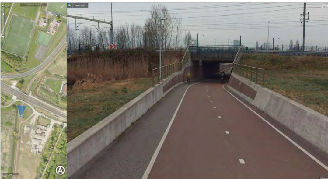
Maarschalkerweerdpad ter hoogte van spoorlijn Utrecht-Bunnik in Utrecht (fietspad tussen strepen 3,8 m breed)
