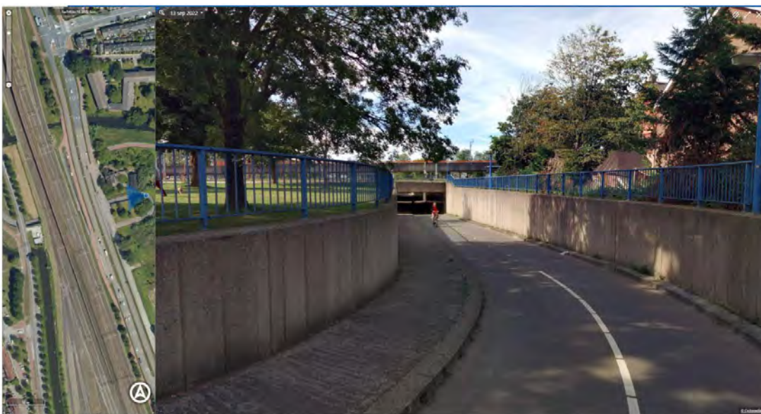
Westerwateringtunnel ter hoogte van Provincialeweg (N203) in Zaandam (fietspad 4,0 m breed)
